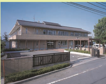
周辺の景観にマッチした特養「すどの杜」外観
